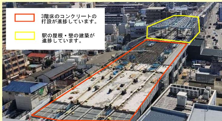
3階床のコンクリートの打設が進捗しています。
