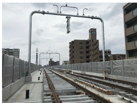
電気工事状況
