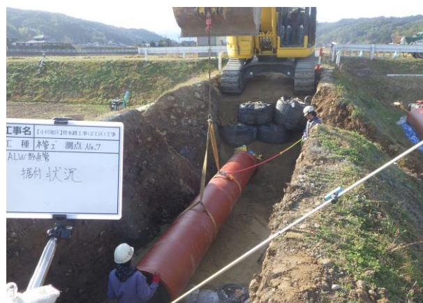
農業水利施設保全対策事業 (小川地区)
