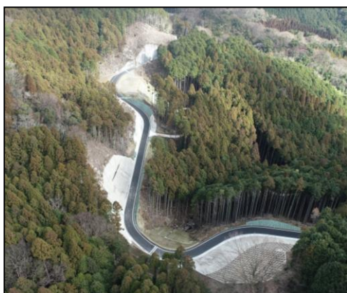
林道の開設状況(西犀川線)
