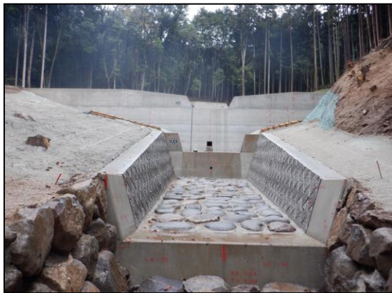
治山事業の施工状況(みやこ町)
