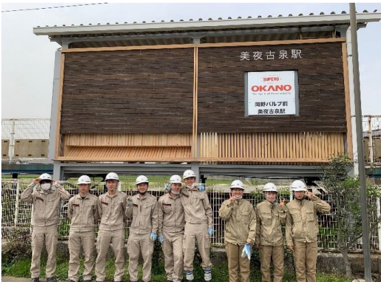
平成筑豊鉄道「美夜古泉駅」 駅舎の木質化
