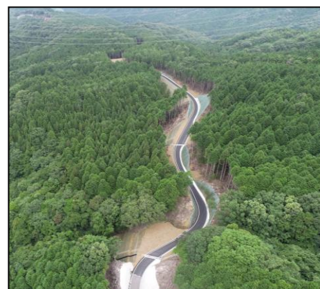
林道の開設状況(国見山線)
