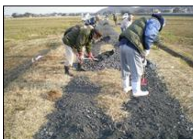
農道の補修作業 (多面的機能支払)
