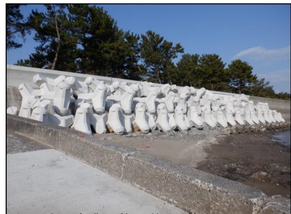
治山事業の施工状況(築上町)
