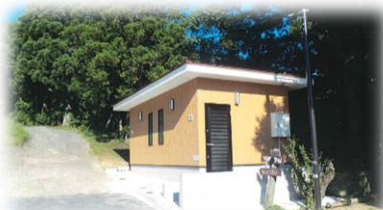
キャンプ場のトイレ整備
