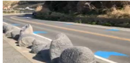
サイクリストのための矢羽根型路面標示
