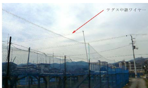
写真13 テグスの下支えにワイヤーを設置した例
