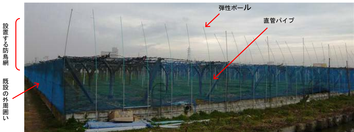
写真3 直管パイプを地中に打ち込んで、その中に弾性ポールを差し込む、より安定度が高い方法。
