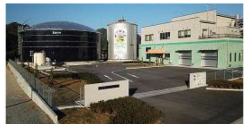
みやま市バイオマスセンター「ルフラン」
