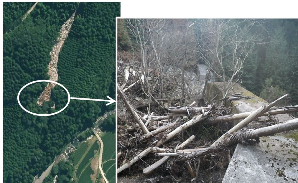
山地災害から人家や道路を守る治山ダム
