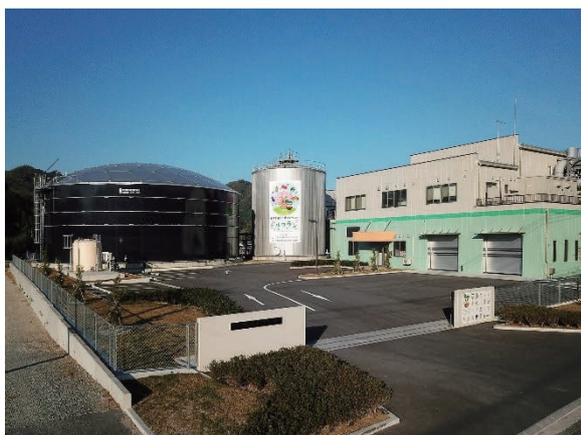
市内全域で生ごみを分別収集し、し尿・浄化槽汚泥と混ぜ合せメタン発酵させ電力と温熱を生成しているほか、発酵後の消化液は「みのるん」として農業に利用しています。
