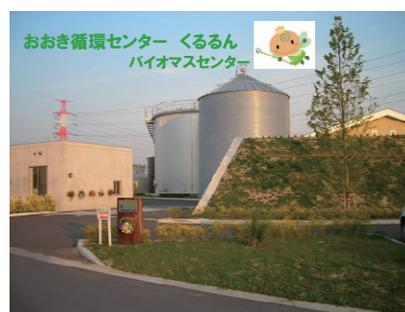
「くるるん」では、町内から排出される生ごみ・し尿・浄化槽汚泥をバイオガスプラントでメタン発酵させ、発生したバイオガスは発電などエネルギーとして利用、発酵後の消化液を有機肥料として町内で活用するなど、本来廃棄物として処理をしていたものをバイオマス資源として活用しています。メンテナンスも容易で不要物がほとんど出ない効率的なシステムとなっています。
