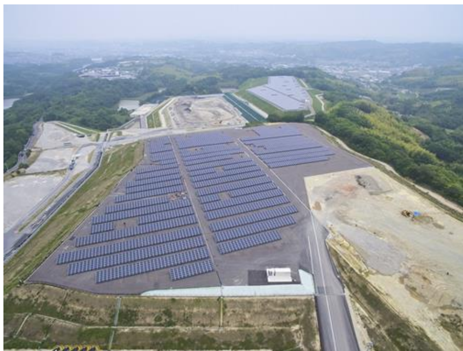
Ảnh: Ví dụ về ứng dụng mặt bằng đất đai (Nhà máy phát điện năng lượng mặt trời: DINS Megasolar)
