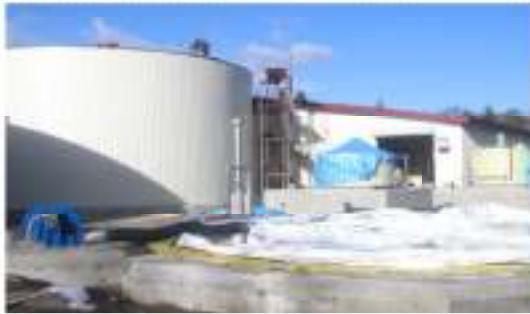
北海道七飯町での牛糞尿、食品生ごみからのバイオガス製造実証プラント (株式会社エネコープ)
