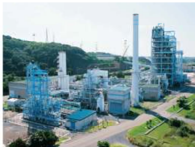
パイロット試験設備 電源開発株式会社若松研究所(北九州市)
