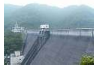
ちくし発電所 550kW (那珂川町)
