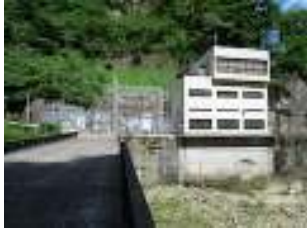
大淵発電所 7,500kW (八女市)
