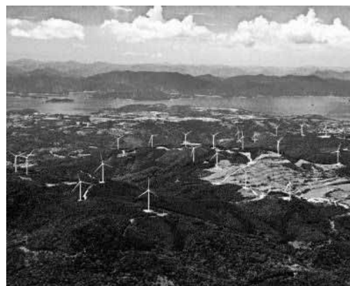
長島風力発電所(出力50,400kW)
