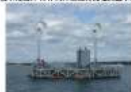
博多湾 浮体式洋上風力発電実証試験(環境省)
