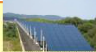
リアモーターカー実験施設のガイドウェイを活用した太陽光発電パネル (宮崎県都農町)出典：環境経済グループ
