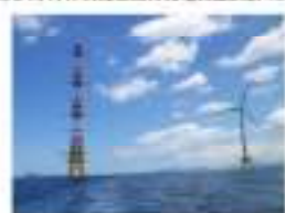
北九州沖 洋上風力発電実証研究(経済省・NEDO)
