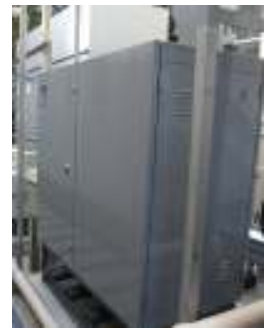
ガスガバナ (変圧器)
