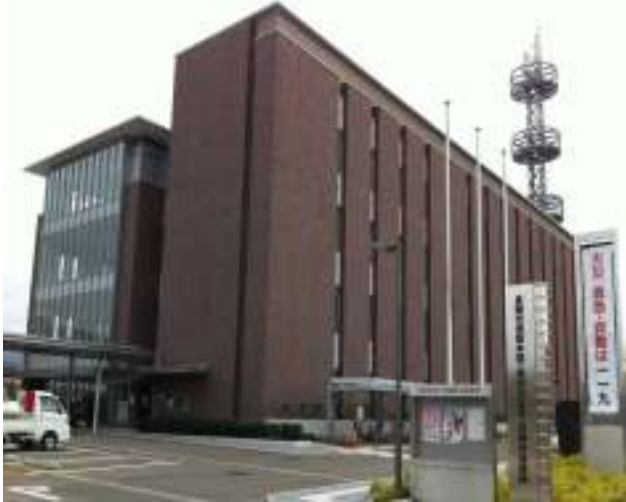
長岡市消防本部 外観
