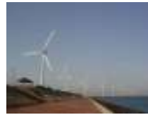
風力発電設備
