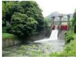
木屋発電所 6,000kW (八女市)
