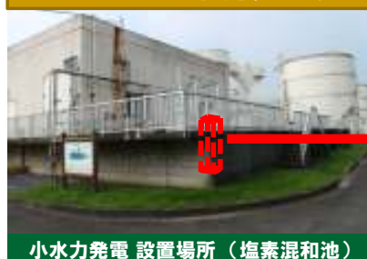
小水力発電(5.3kW)
