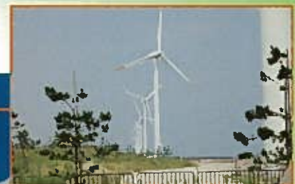
エヌエスウインドパワーひびき 響灘風力発電所 1.5MW×10機
