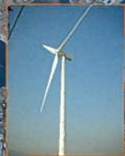
テトラエナジー ひびき風力発電所 2MW×1機
