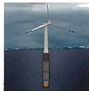
浮体式：浮体施設をチェーン等で海底に固定。水深50～200m
