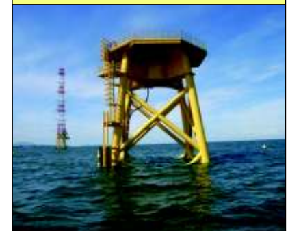
支持構造物設置完了
