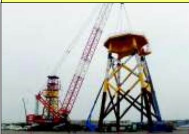
支持構造物 ジャケット製作状況
