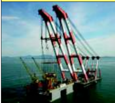
支持構造物 玉掛状況
