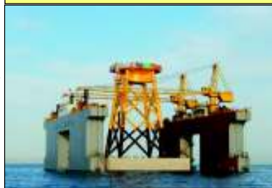
支持構造物 係留状況
