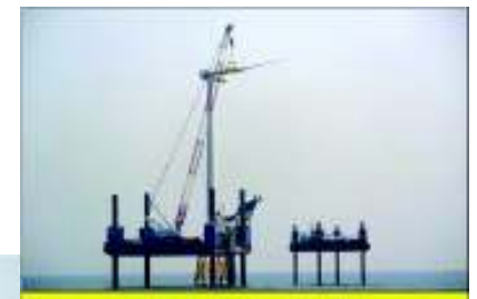
2013年3月17日 ブレードNo.1据付
