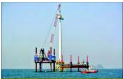
2013年3月12日 一体化型ナセル据付
