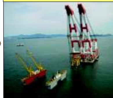
FD2次注水、位置合わせ状況
