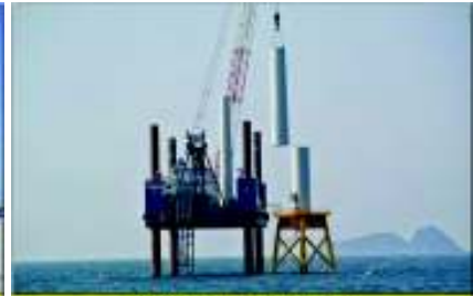
2013年3月6日 ミドルタワー据付
