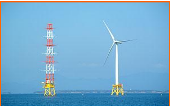
NEDO/JPOWER実証研究事業 風況観測鉄塔/2MW×1機(H25.6稼動)
