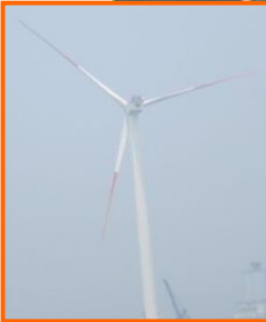
ジェイパワーひびき 風力発電所 2.7MW×1機(H25.9稼動)
