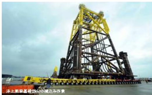
洋上風車基礎部分の積み込み作業
