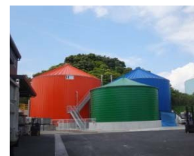
メタン発酵槽・消化液槽
