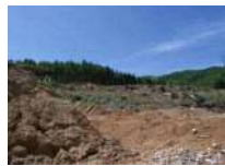
住宅地造成のための森林伐採
