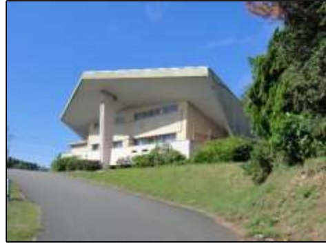
志賀島ビジターセンター(福岡市)
