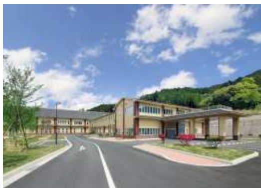
田川地区クリーンセンター
