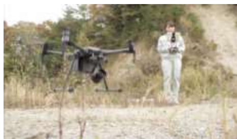
ドローンによる測量
