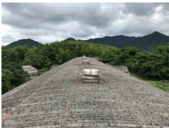
特殊石灰資材 施工前
