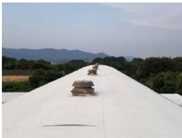
特殊石灰資材 施工後
