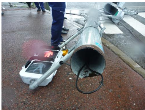
倒壊した信号柱
