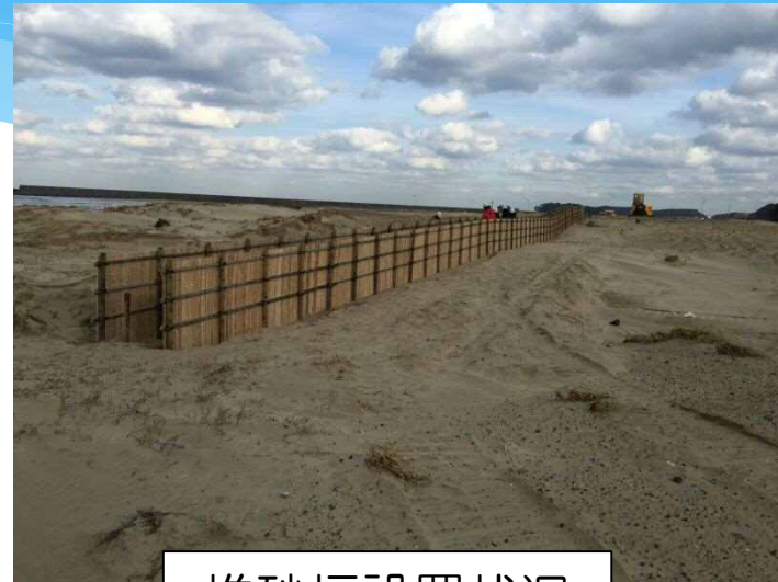
堆砂垣設置状況
