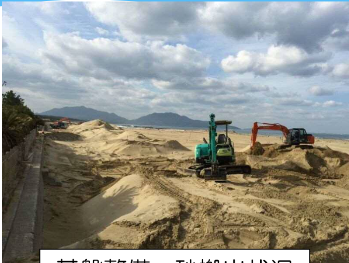
基盤整備・砂搬出状況
