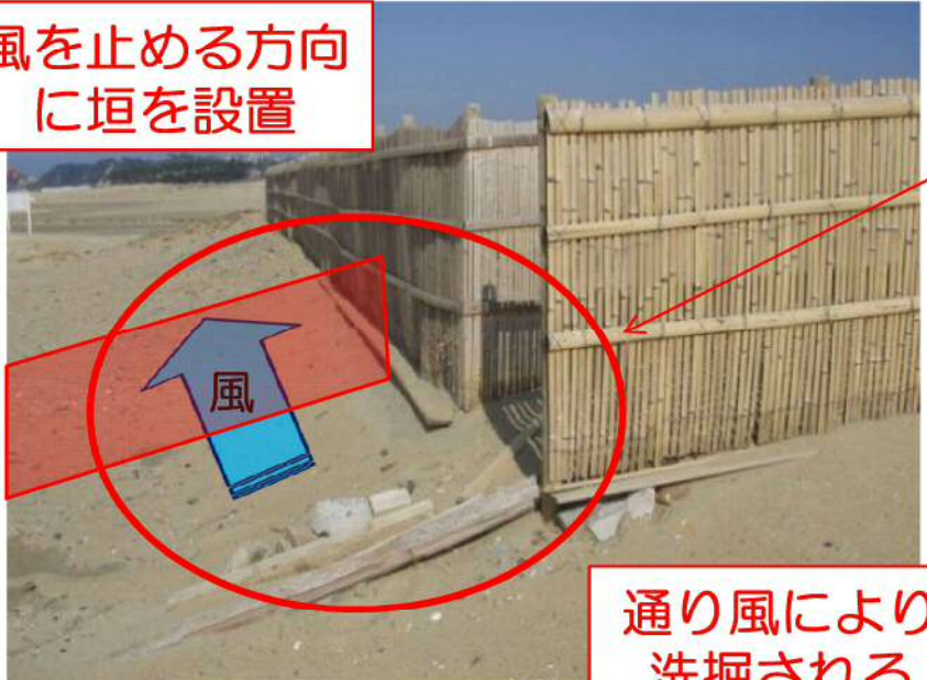
試験施工の洗掘箇所
