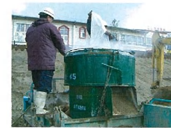
土、固化材 混合
