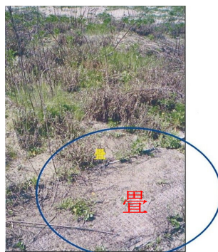
古畳を敷き並べることにより、直接的な飛砂を防止するとともに、植生の基盤材として有効であるか判断するため20畳分設置しました
