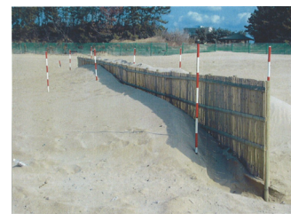
(設置後1ヶ月) 柵の前後に砂の堆積がみられます。堆積量を測定し、最適な構造を検討します
