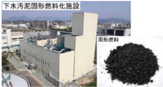
御笠川浄化センターでは、30（2018）年度に発生した下水汚泥のうち、約65%を「溶融施設」、約16%を「油温減圧式乾燥施設」で処理し、残り約19%については場外搬出等を行い、下表のとおり全量を再利用しています。
