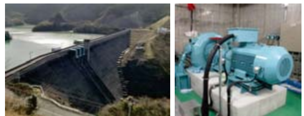
瑞梅寺ダム小水力発電所発電設備
