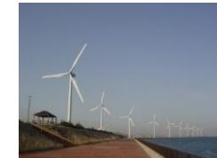
風力発電設備
