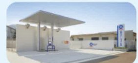
水素ステーション
