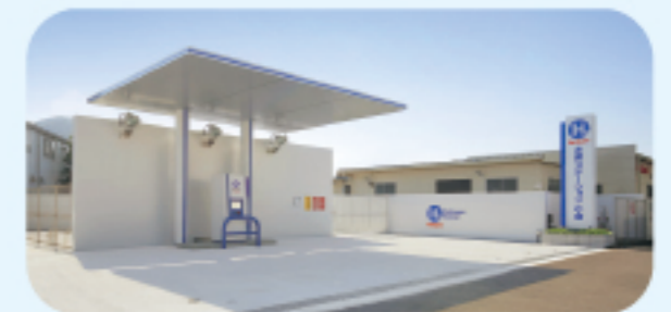
水素ステーション
