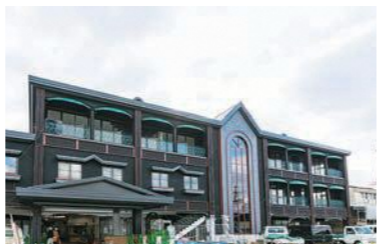
改修中の田川伊田駅。駅と直結した宿泊施設や観光案内所を設置し、新たな観光拠点に生まれ変わる(平成31年4月完成予定)
