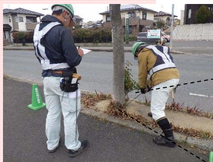
▲専門家による点検の状況
