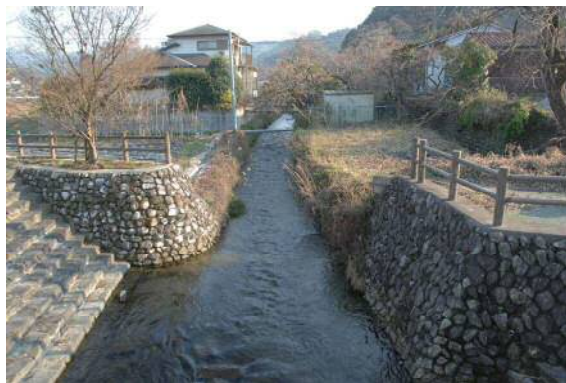
込野廻水路（立花町）
