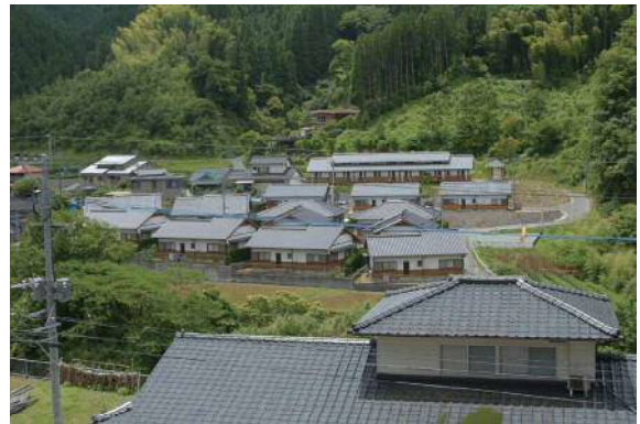
地域の伝統的な形態・意匠で計画された公営住宅の例
