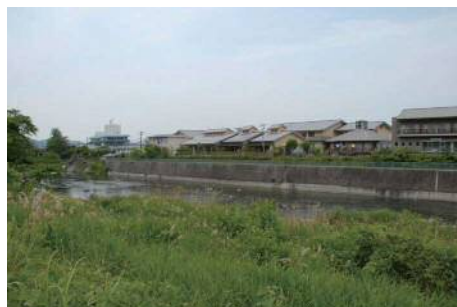
矢部川沿いに建つ「黒木町地域交流センターふじの里」
