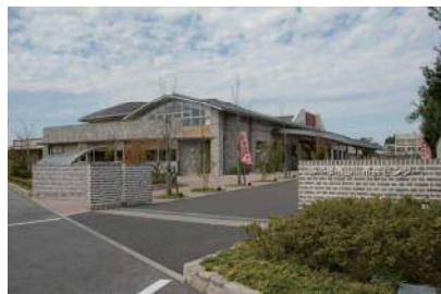
出入口を修景した例 ：みやま市山川市民センター
