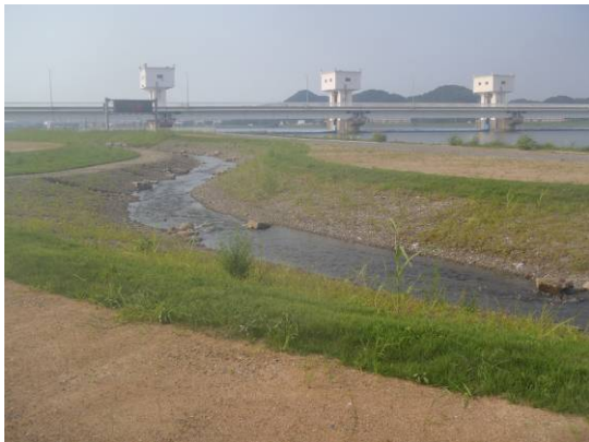
遠賀川河口堰（ぜき）に設けられた多自然魚道。様々な川の生きものがのびやすいように工夫された魚道です。専門家や地域住民の意見を取り入れて造られました。魚道内では多くの回遊性魚類が確認されています。
