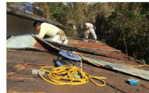
■ 縁側長尺カラー鉄板張替
