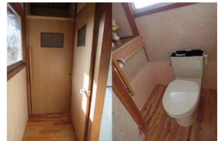
■トイレの簡易水洗化、手すり設置
