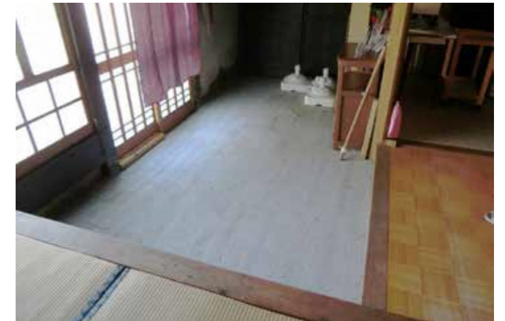
■土間をコンクリートで埋めてかさ上げし、段差を軽減
