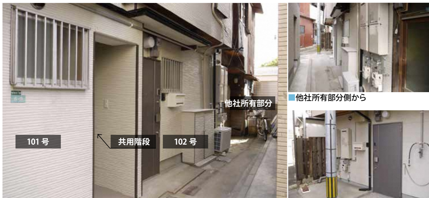
1階概観、共用階段入口付近
