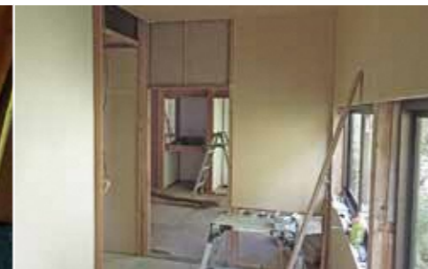
■ 蛭観賞ルーム石膏ボード張及び窓枠取付
