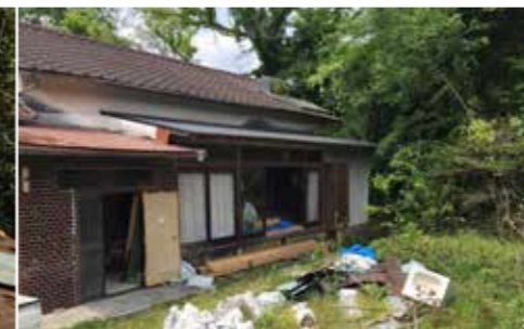
■ 縁側長尺カラー鉄板張完了
