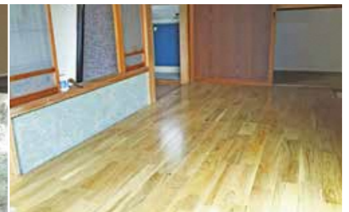
■ 縁側床張替完了
