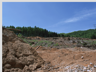
住宅地造成のための森林伐採
