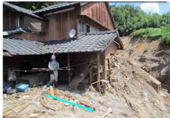
人家被災状況
