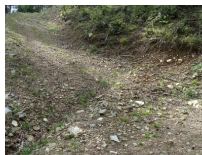
素掘りによる横断溝
