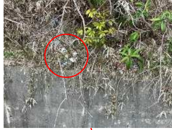
①水路法面(4)
