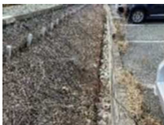
⑦線路のり面(7)
