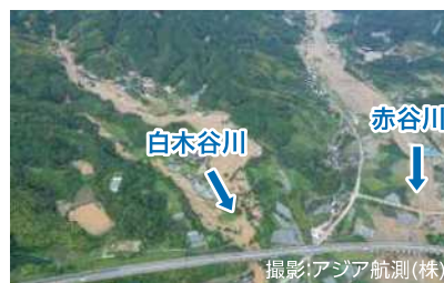
【写真】土石流による河道埋塞 (赤谷川・白木谷川付近)
