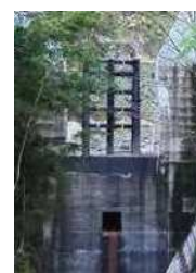
【写真】 今道川既設改築後
