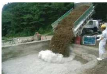
①土砂とセメントを投入
