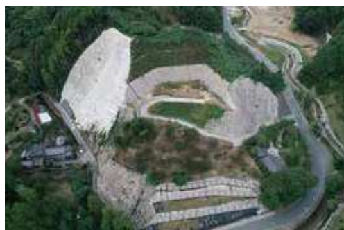
【写真】改良復旧(地すべり)工事後(平榎(2))
