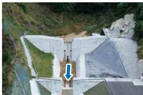
【写真】改良復旧(砂防)工事後(北川(2))
