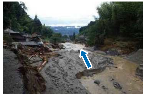
【写真】土石流発生状況(白木谷川)
