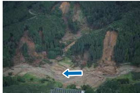
【写真】山腹崩壊発生状況(黒川)
