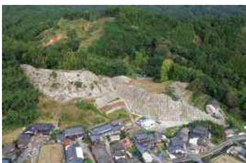
【写真】改良復旧(急傾斜)工事後(蔵谷地区)
