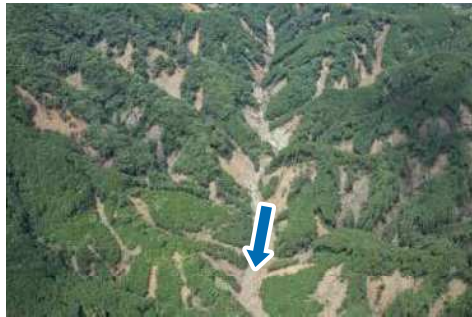
【写真】山腹崩壊発生状況(奈良ヶ谷川上流)
