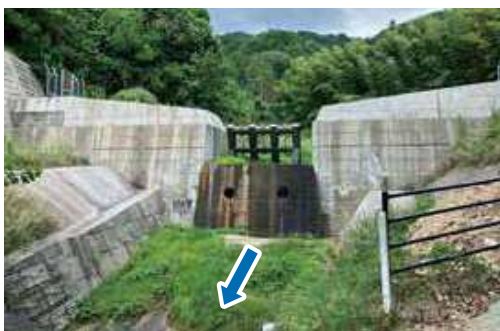
【写真】改良復旧(砂防)工事後(導目木谷川)
