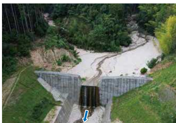
【写真】土砂の捕捉状況(正信川)
