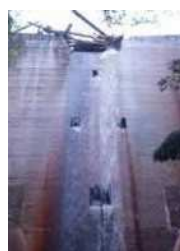
【写真】 今道川既設改築前
