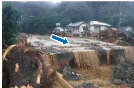
【写真】土石流発生状況(正信川)
