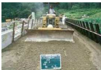
③内部材の敷均し
