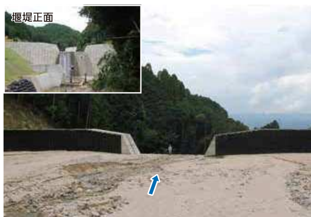
【写真】堰堤背面の堆砂状況(白木谷川)
