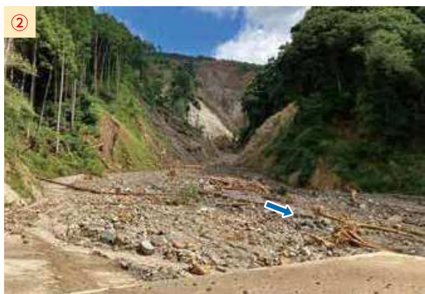
【写真】崩壊および流木・土砂の捕捉状況(船底谷川)
