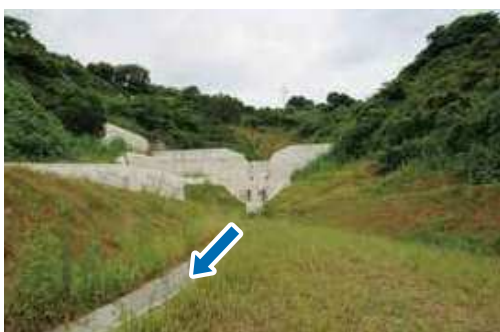
【写真】改良復旧(砂防)工事後(山の神谷川)
