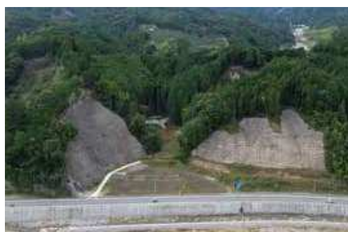
【写真】改良復旧(急傾斜)工事後(真竹地区)
