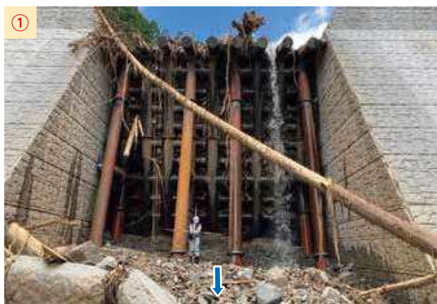
【写真】流木・土砂の捕捉状況(船底谷川)
