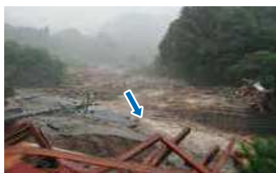
写真① JR橋梁（平迫橋）付近
