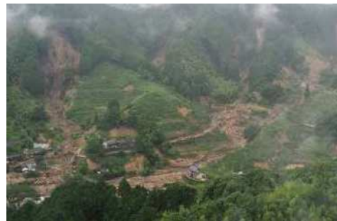
【写真】地すべり発生状況(平榎地区)
