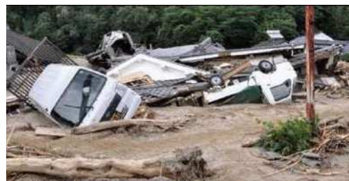
【写真】土石流により全壊した住家 (朝倉市黒川星丸)
