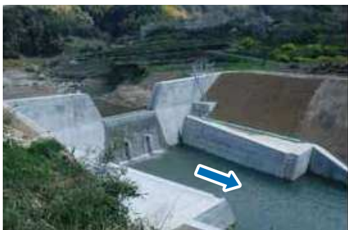
【写真】原形復旧工事後(北川)
