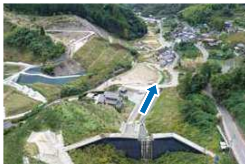
【写真】改良復旧(砂防)工事後 北川右支川
