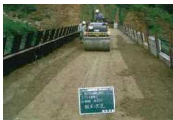
④小型ローラで転圧・締固め
