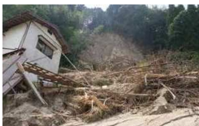
【写真】急傾斜地の崩壊により全壊した住家 (朝倉市黒川松末 真竹地区)
