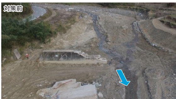
【写真】北川301号砂防堰堤
