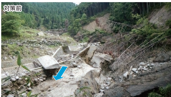
【写真】白木谷川砂防堰堤
