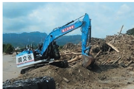
【写真】土砂や流木の撤去に着手 H29.8.15
