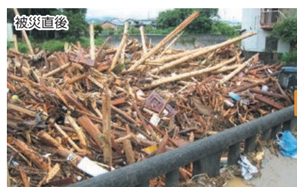
【写真】河川の応急復旧（流木撤去）
