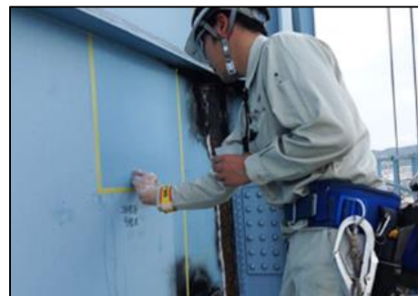
腐食劣化診断の様子
