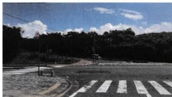
ナブコ側交差点、見通しの悪かった サイエンスパーク入口草木伐採整備
