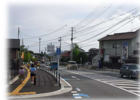
<通学路の歩道整備>
