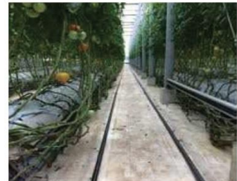
図 2-3-1 底面等をコンクリート等で覆う農作物栽培高度化施設
