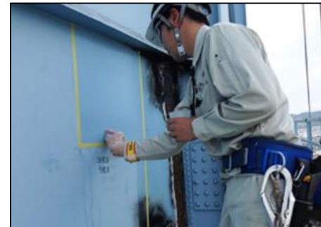
腐食劣化診断の様子
