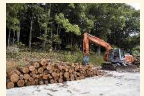
集出荷場(土場の舗装)
