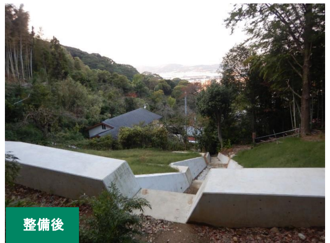
豪雨災害により荒廃した溪流に谷止工・流路工を整備（北九州市八幡東区）
